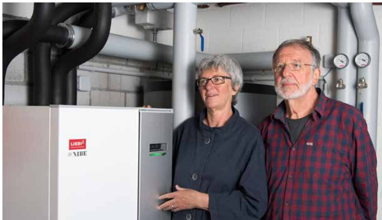
Käthi Rubin und Bernd Adam mit ihrer Sole/Wasser-Wärmepumpe, einer invertergesteuerten NIBE F1155.
