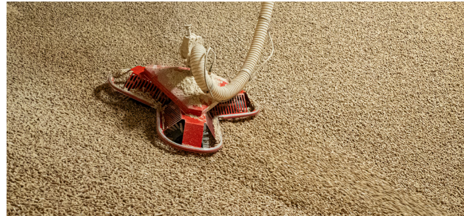
Hier im Pelletlager verbaut, ist eine Pelletsaustragung mit Maulwurf vom Typ E3.
