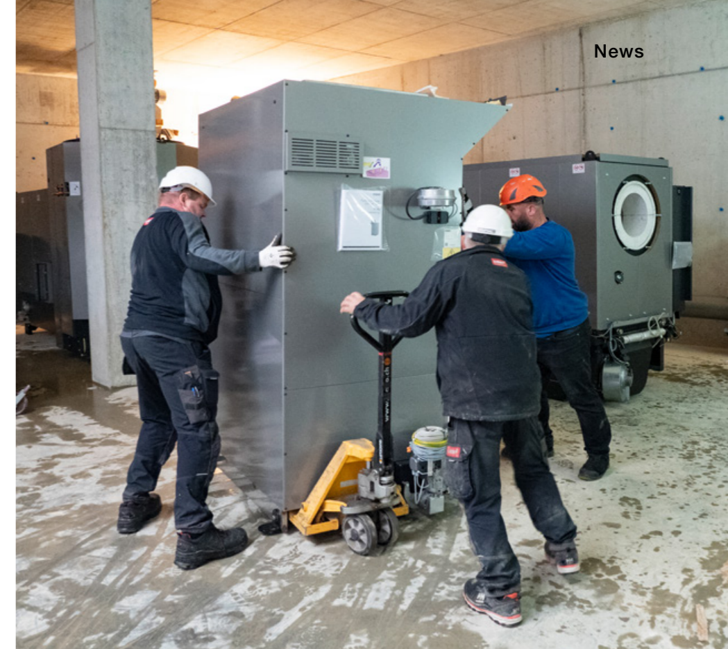
Die Einbringung der Kessel an der Grossanlage war ein logistischer Kraftakt.
